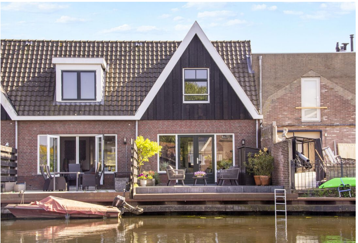
Hoge Rijndijk 14, Nieuwerbrug Aan Den Rijn
